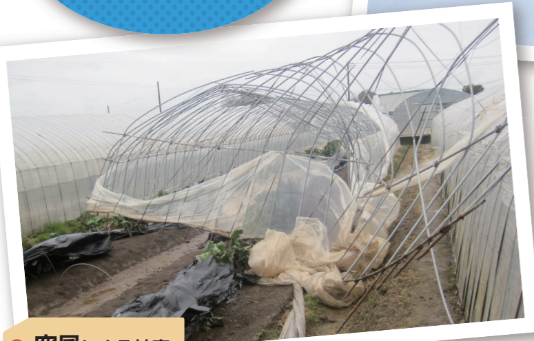
突風による被害
